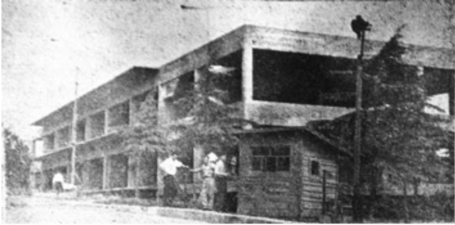
Bekâr İşçi Pavyonu Birinci Kısım İnşaatı (1959) (Seka Postası, 1 Kasım 1959)
