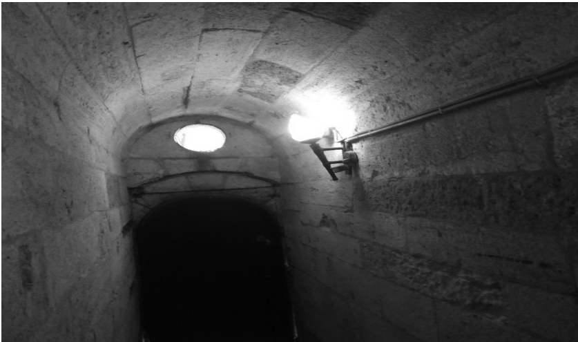
10. Beşik tonozla örtülü, kulenin esas merdiven kısmına giden bölüm. 14/04/2017'de çekilmiştir.
