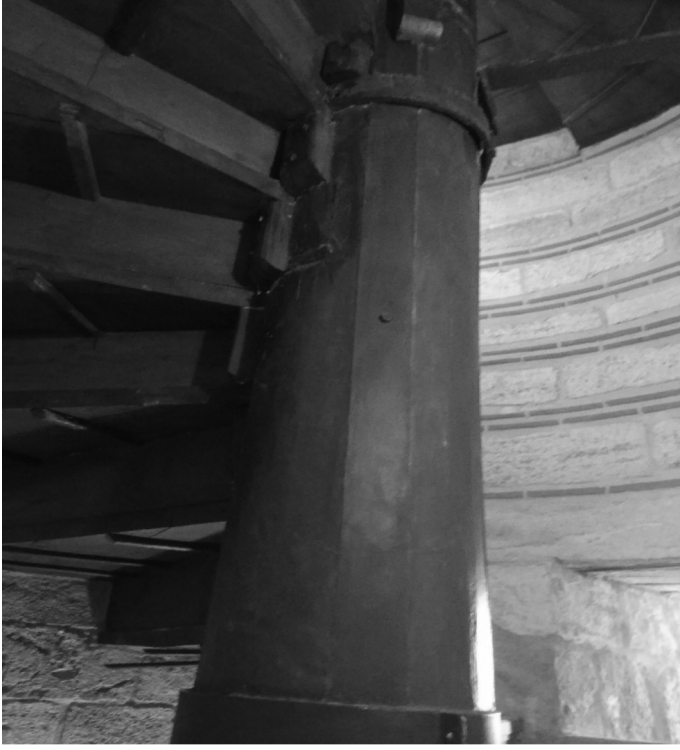
11. Kulenin ahşaptan merdivenleri. Aynı zamanda almaşık örgülü duvar, pencere kısımları görülebiliyor. Foto: Deniz Vatansever, 14/04/2017.
