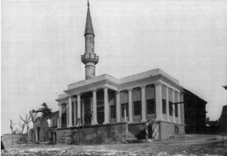
Eski Nizâm-ı Cedîd Karakolu binası (Anadolu Kulübü) ve geride Adliye Cami'nin minaresi (Erişim: Eylül 2016, http://eski.istanbulium.net/post ).
