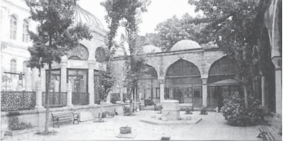
Köprülü Külliyesinin avludan görünümü
