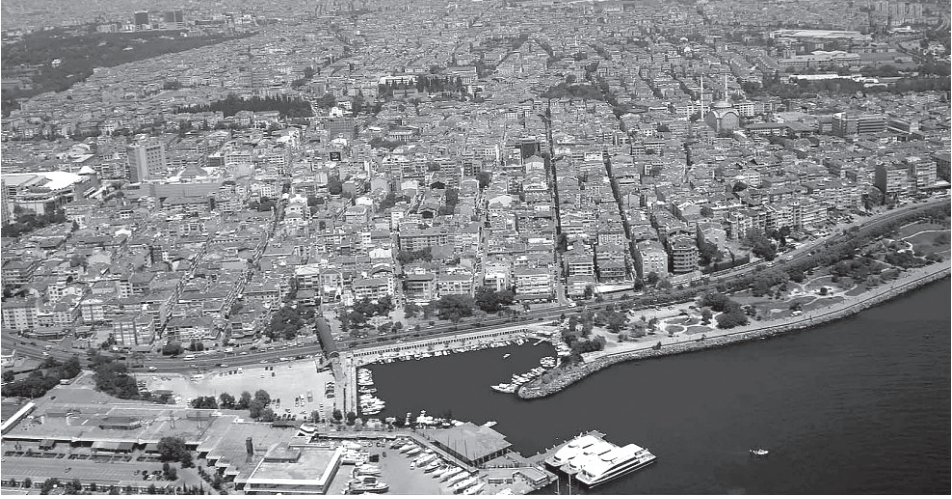
Foto 25. Binalar eski kıyı çizgisi, karayolu ve deniz tarafındaki tesisler dolgu alanı üzerinde
