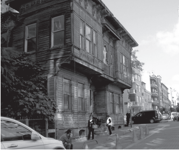
Foto 17. Banyolar Sokak'ta ahşap ev
